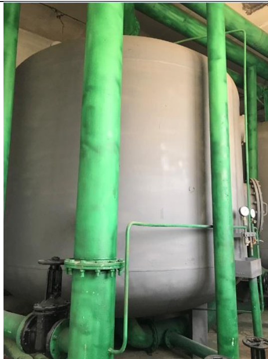
Большие фильтры для очистки воды
