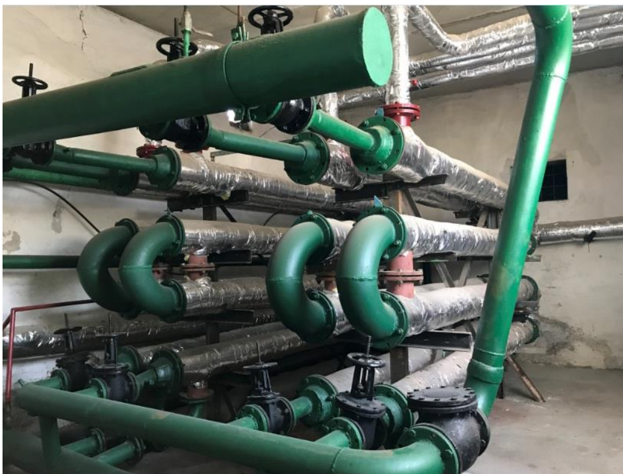
S-образные трубы для нагрева и предупреждения остывания воды
