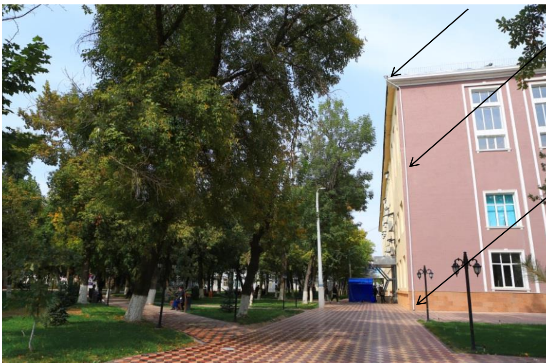
Ливневый сток с крыши главного здания кампуса 1
