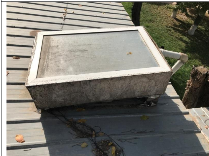
Кампус 1. Гелиокамера для аккумуляции солнечной энергии
