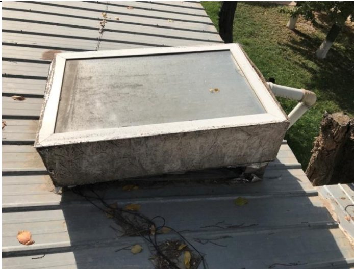
Кампус 1. Гелиокамера для аккумуляции солнечной энергии
