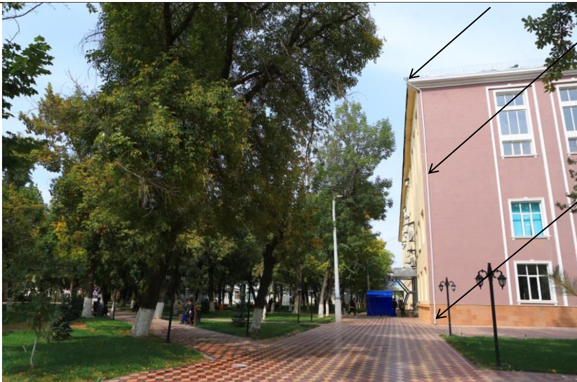
Дождевой сток с крыши главного корпуса кампуса 1
