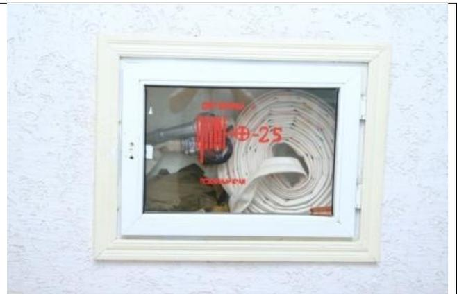
Пожарный гидрант внутри здания.
