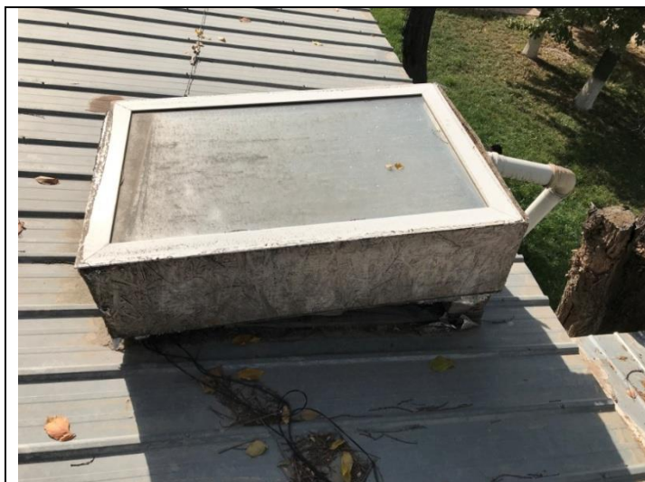
Кампус 1. Гелиокамера для аккумуляирования солнечной энергии
