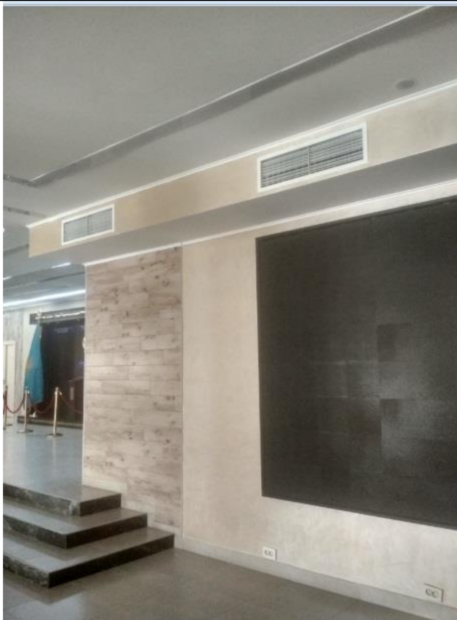
Естественная вентиляция в Кампусах университета
